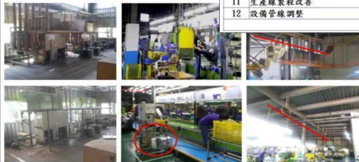
冷水機管線串聯
