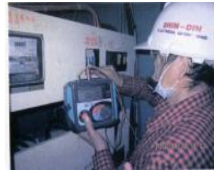
低壓設備檢測『合格』
